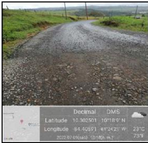
Foto N.º. 37 Foto N.º. 38 Se muestra ausencia de cunetas revestidas en pendiente y agrietamiento de la carpeta asfáltica.
