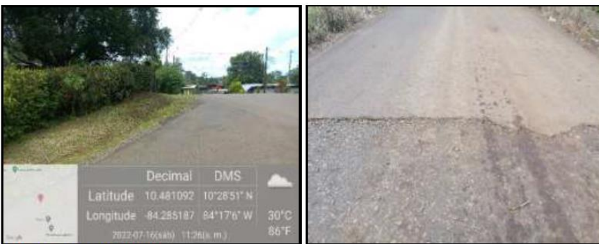
Foto N.º 102 Foto N.º 103 Primera foto muestra el inicio del proyecto, intersección con camino 2-10-057. Segunda foto muestra el final del proyecto y continúa en superficie de lastre.
