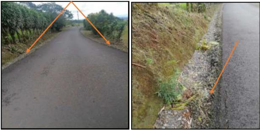
Foto N.º. 37 Foto N.º. 38 Se muestra ausencia de cunetas revestidas en pendiente y agrietamiento de la carpeta asfáltica.
