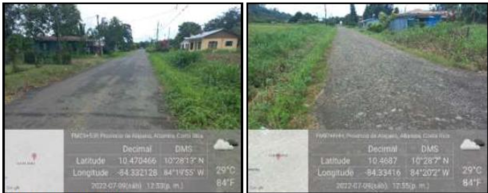
Foto N.º 76 Foto N.º 77 Se muestra en ambas fotos la transición entre lastre y carpeta asfáltica.
