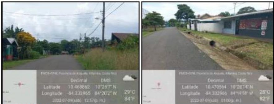
Foto N.º 80 Foto N.º 81 En la primera foto se ubicaron más cunetas en abandono y en la segunda se observa cuneta revestida con ausencia de acera y espaldones.
