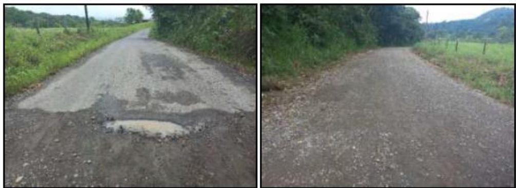
Foto N.º 64 Foto N.º 65 Final del camino intervenido con mezcla asfáltica. Continúa el camino en lastre no se observa población.
